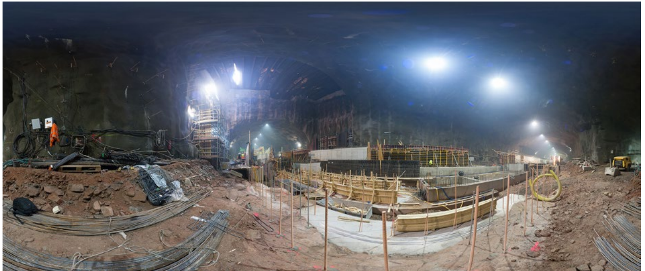
Kuva 6. Panoraamakuva rakenteilla olevasta Matinkylän metroasemasta. © Lemminkäinen & H. Kauhanen
