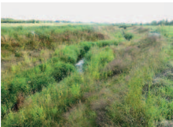
Kuva 4. Perniön Juottimenoja (yllä vas.), Sipoon Ritobäcken (yllä oik., rakentamisvaiheessa) ja Tyrnävän Leppioja (vas.) ovat edustavimmat esimerkit ympäristönäkökohtia edistävän kaksitasoisen uomapoikkileikkauksen käytöstä maatalouden peruskuivatuksessa Suomessa.
