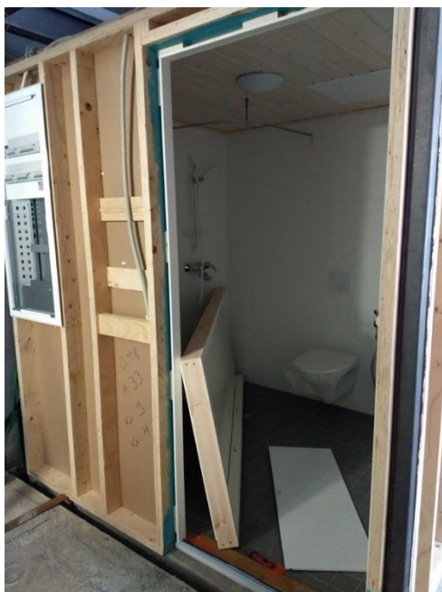
Kuva 2. Kylpyhuonemoduuli, jonka talotekniikka on asennettu tehtaalla valmiiksi.
