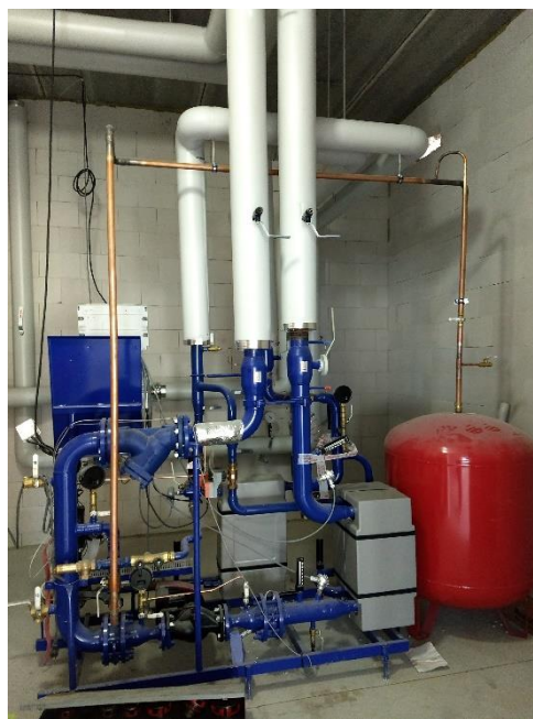
Kuva 3. Lämmönjakokeskus.
