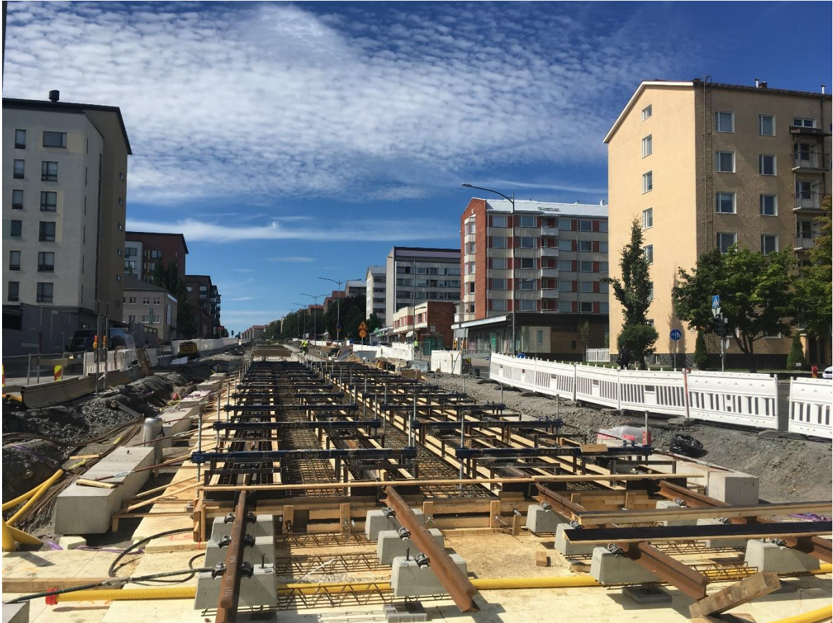
Kuva 42: Sammonkadun ratikkatyömaa Tampereella kesällä 2018.
