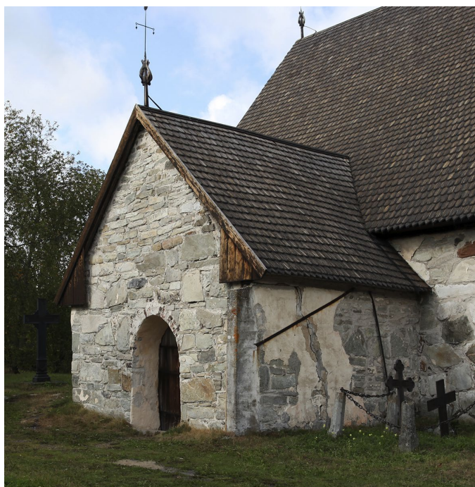
Kuva 8. Asehuoneen pienemmistä kivistä muurattu päätykolmio lienee kirkontilien tietojen perusteella vuodelta 1678 eli pari vuosikymmentä myöhäisempi kuin asehuoneen kattorakenne. Kuva: Livady.
