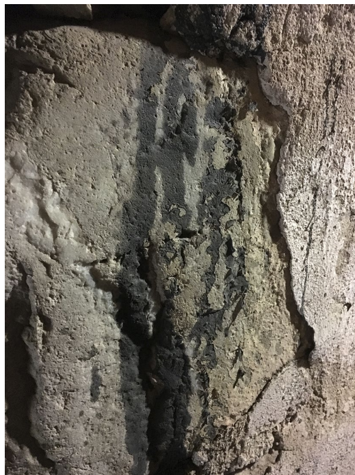
Kuva 9. Runkokuoneen eteläseinässä asehuoneen ullakolla on nähtävissä runkokuoneen eteläseinän rappauksen puuttuminen asehuoneen päätyseinien yläpuolisilta, asehuoneen katon alle jääviltä osin. Kuva: Livady.
