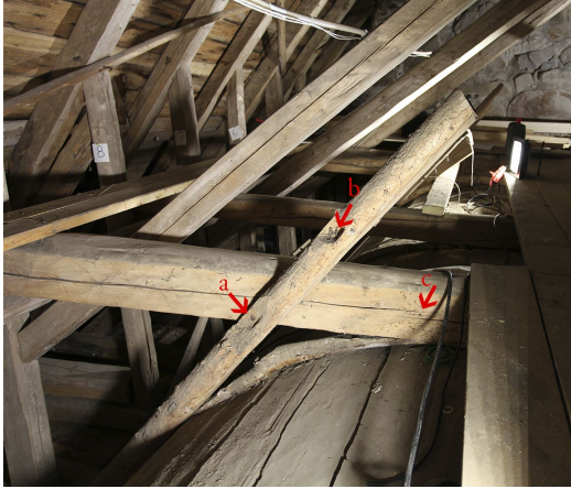
Kuva 11. Laipion rakenteen muutos näkyy selkeästi lähes kaikissa ruoteissa. Kuva pohjoispuolen neljännessä ruoteesta idästä lukien. a) nykyinen naulaus, b) aiempi naulan kolo ruoteessa, c) naulanreikä laipion niskassa. Kuva: Laura Laine.
