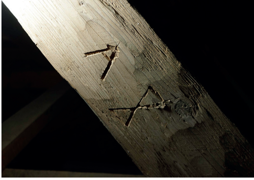
Kuva 8. Tekijämerkki Pohjan kirkon kattotuoleissa. Kuva: M. Tolonen.
