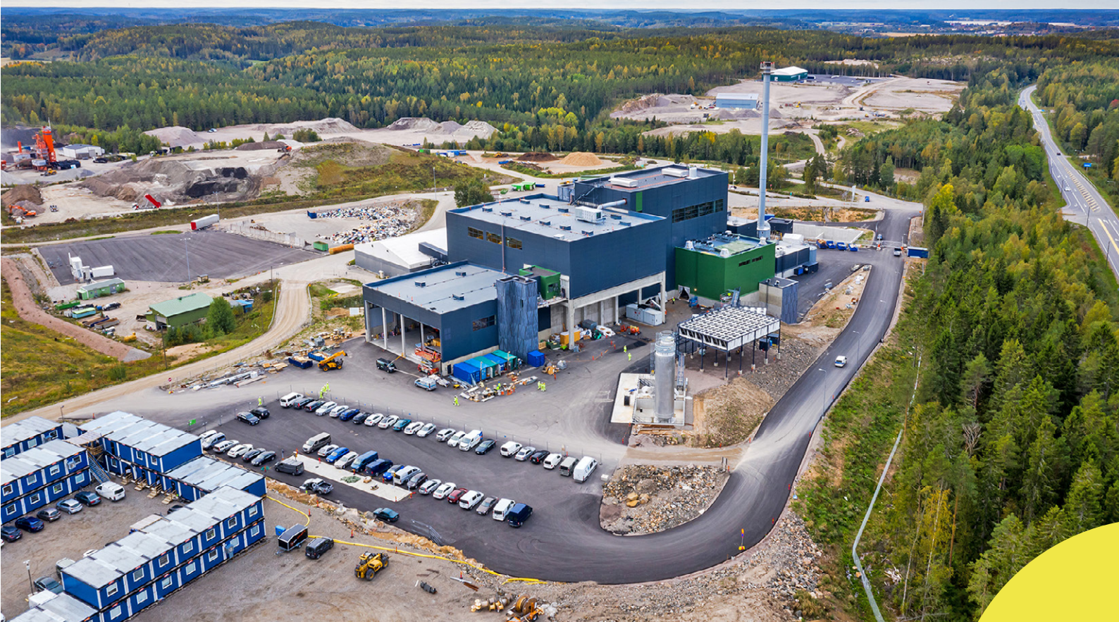
Kuva 24. Kuva Salon Seudun Sanomissa 13.7.2020. Voimalan ulkotyöt ovat lähes valmiit. Kuvaaja Jan Sundman/Salon Seudun Sanomat.
