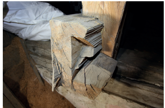
▲▲ Kuva 10. Alapaarteiden katkaisemisen yhteydessä kattotuoleja vahvistettiin vastakkaiset konttipuut yhdistävällä vetoparrulla. Liitosten pitkiksi jätetyt tammitapit poikkevat puulajiltaan kattorakenteen muusta puutavarasta. Kuva: Mia Puranen.
