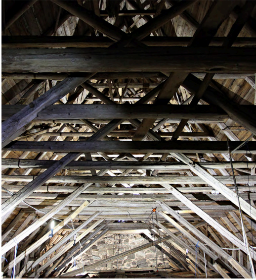
Kuva 8. Keminmaan vanhan kirkon 1550-luvun vesikattorakenteita. Kuva: Livady.
